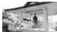
梵鐘を吊るしている鐘楼が老朽化により崩れる恐れがあるため、立坂山地区公民館では、耐震補強工事費の寄付を募っています。 問合せ 坂山地区公民館 TEL72-2267
