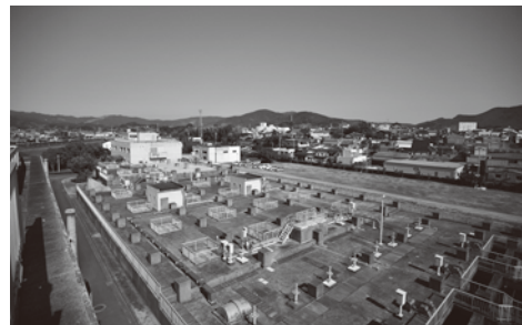
下水道処理施設
