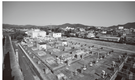
下水道処理施設
