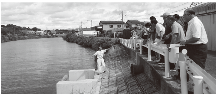
平田瀉下流排水機場樋門ゲート改良工事の調査
