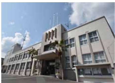
▲耐震補強工事を行った市役所本庁舎
