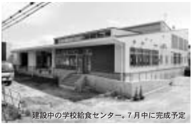
建設中の学校給食センター。7月中旬に完成予定
