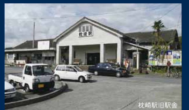
枕崎駅旧駅舎
