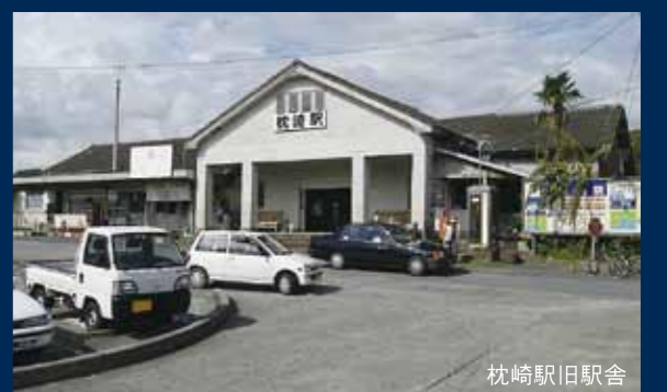
枕崎駅旧駅舎
