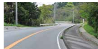
▲塗木一枕崎間(約14km)は、既存の県道を活用します。坂道でカーブの多い中原工区(写真)は改良工事にとりかかっています。
