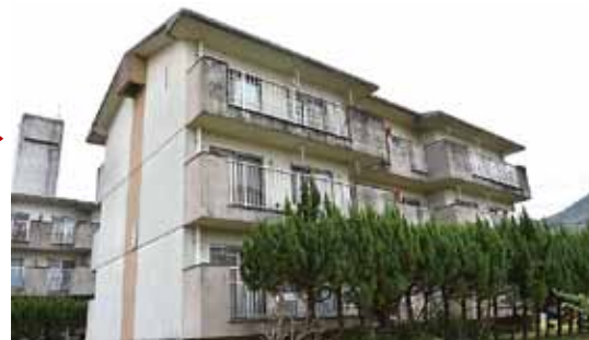
▲市営住宅の長寿命化計画に基づき、岩戸団地等の長寿命化工事を実施します。
