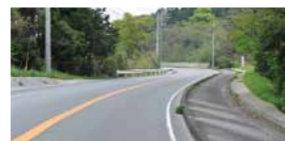
▲塗木一枕崎間(約14km)は、既存の県道を活用します。坂道でカーブの多い中原工区(写真)は改良工事にとりかかっています。
