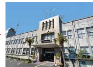
▲災害時の拠点となる市役所本館の耐震補強工事を実施します。
