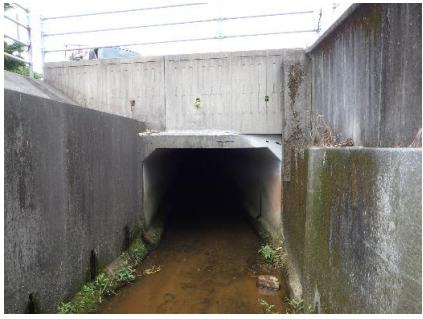
19 みぞめばし 美初橋 プレシト桁橋
