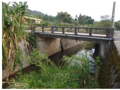
22 したんかわばし 下河橋 プレシト桁橋
