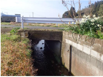
16 いぬむたばし 犬牟田橋 ボックスカルバート
