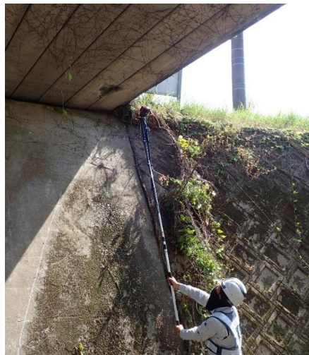
ポールカメラによる点検状況
