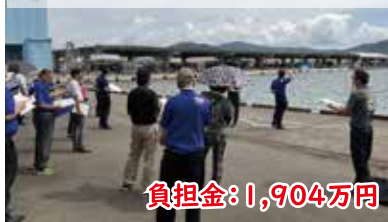
広域漁港整備事業(特定)負担金 (-6.0m岸壁(改良)地盤改良・岸壁整備L=80m)
