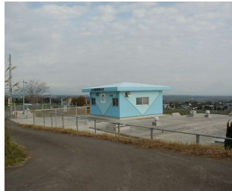
俵積田配水池
