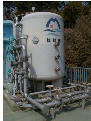
硝酸性窒素除去装置
