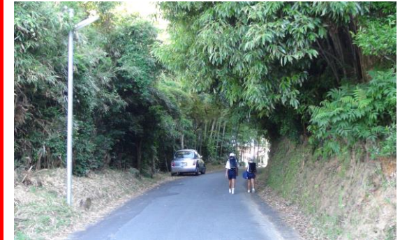
⑫妙見神社の裏 がけくずれの危険あり
