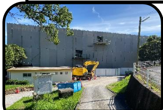
工事の様子(坂道側)
