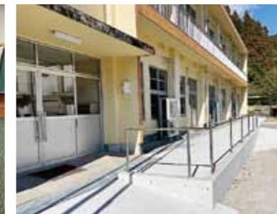
▲出入口をバリアフリー化
