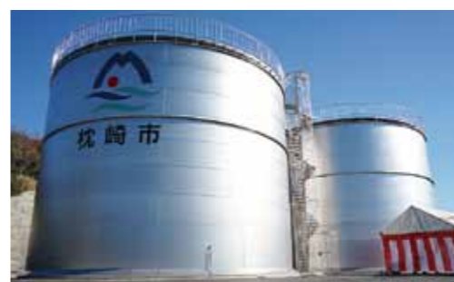
▲更新後の第1、第2配水池本体
