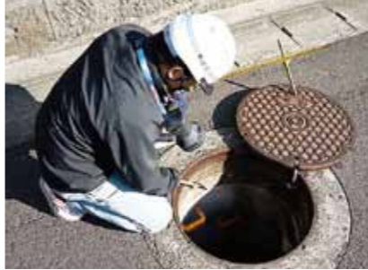
▲打診して腐食等を確認する
