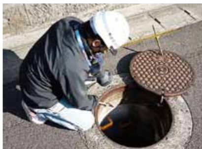
▲打診して腐食等を確認する
