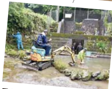
水源地等の 清掃作業を実施
