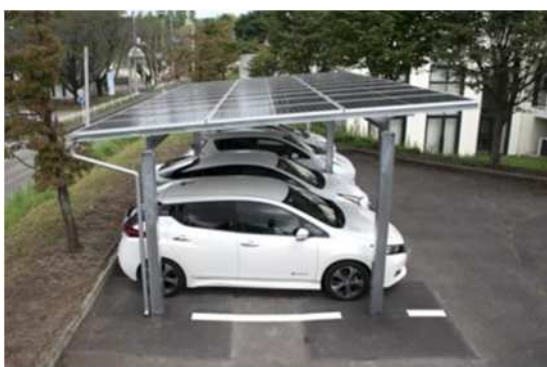
図 49 PPA 事業によるソーラーカーポート導入事例
