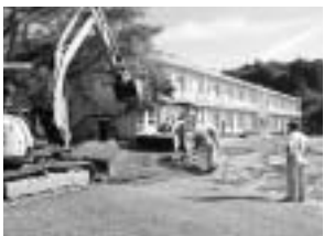
枕崎建設業組合青建会・花渡川安全協議会が金山小グラウンドを整備
