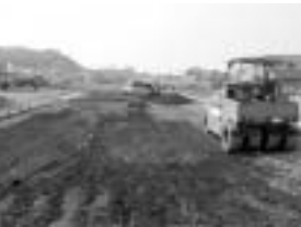
建設が始まるタイヨー枕崎店
