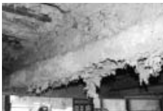
アスベストを使った建築物 (資料写真)
